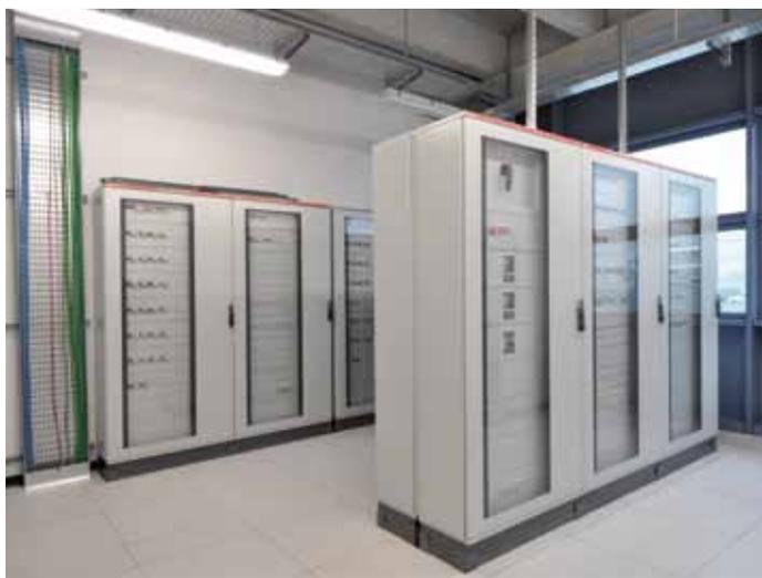
Tutti i quadri di protezione e di controllo sono centralizzati in un'unica struttura.
